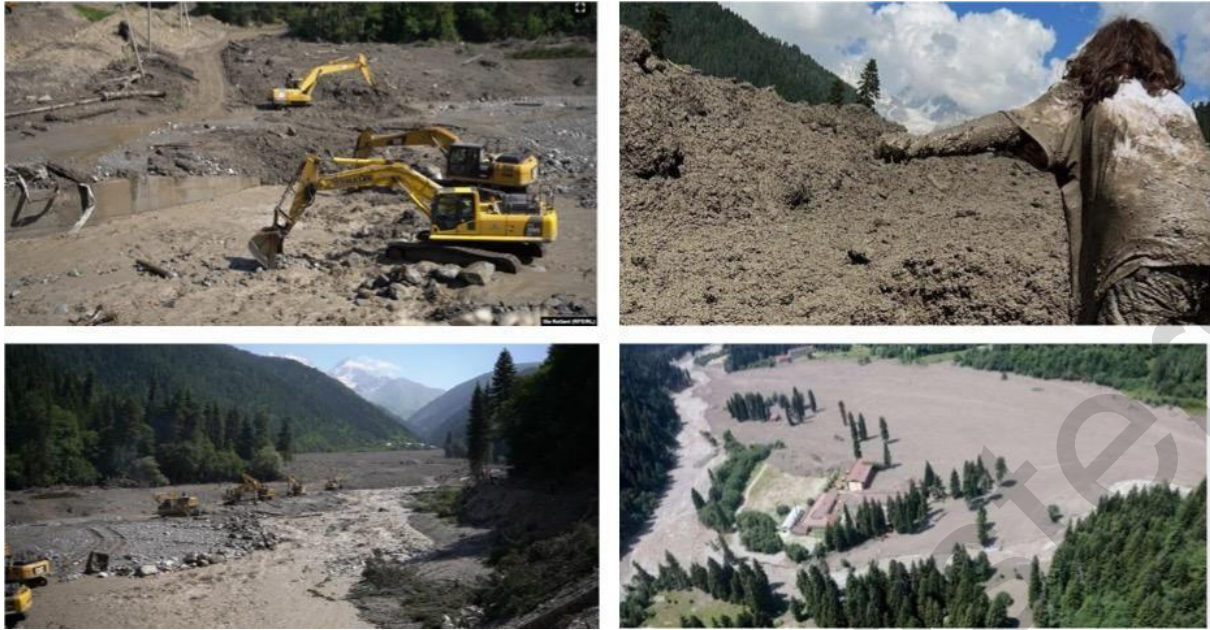
Σχήμα 3.26. Φωτογραφίες της κατολίστησης στο Σοβί.
