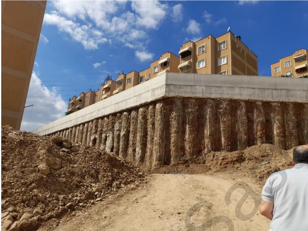
Σχήμα 3.20. Νεόκτιστος τοίχος αντιστήριξης
