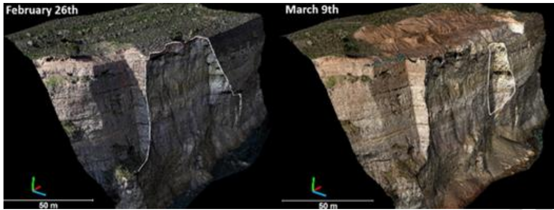
Εικόνα 3.23. Σημεία αποτυχίας πλαγιάς της Διώρυγας της Κορίνθου στις 26 Φεβρουαρίου και στις 9 Μαρτίου από το Pix4d.
